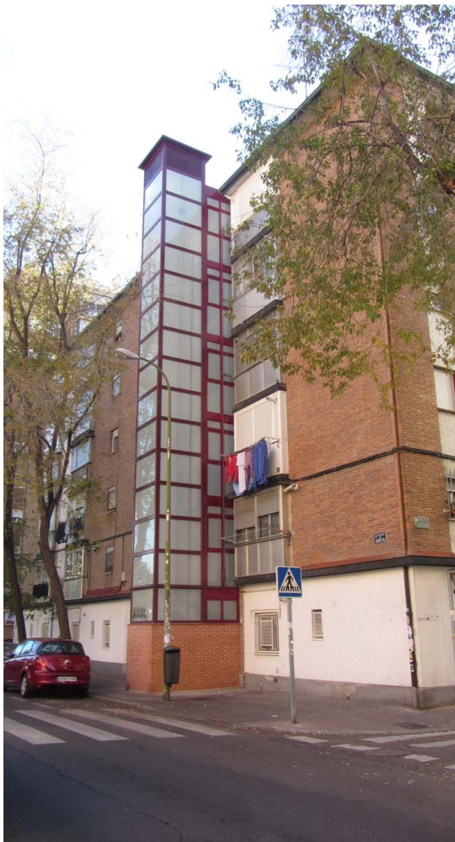
Instalación de ascensor
