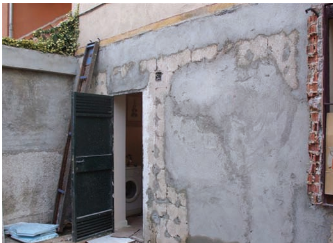
Derribo de ampliación bajo cubierta y en espacio libre de parcela en calle Luis Larrainza. Distrito de Chamartín
