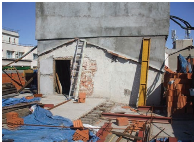
Demolición de elevación de cubierta en calle Fuencarral. Distrito de Centro
