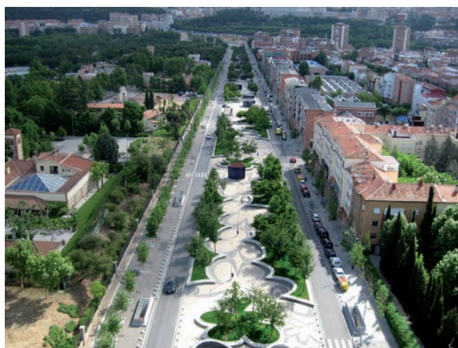
Acondicionamiento de la avenida de Portugal tras el soterramiento de la A-5. 2007
