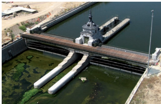
Presa número 5, al norte del Puente de Segovia. Obras de remodelación iniciadas en 2008
