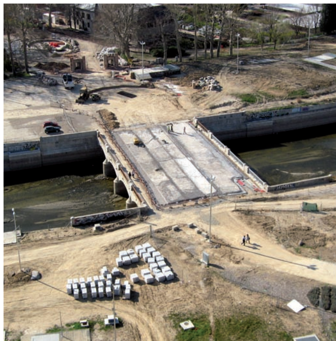
Puente del Rey. Obras de remodelación iniciadas en 2008
