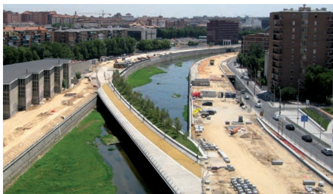
Puente Oblicuo. Obras de consolidación, urbanización y peatonalización iniciadas en 2008
