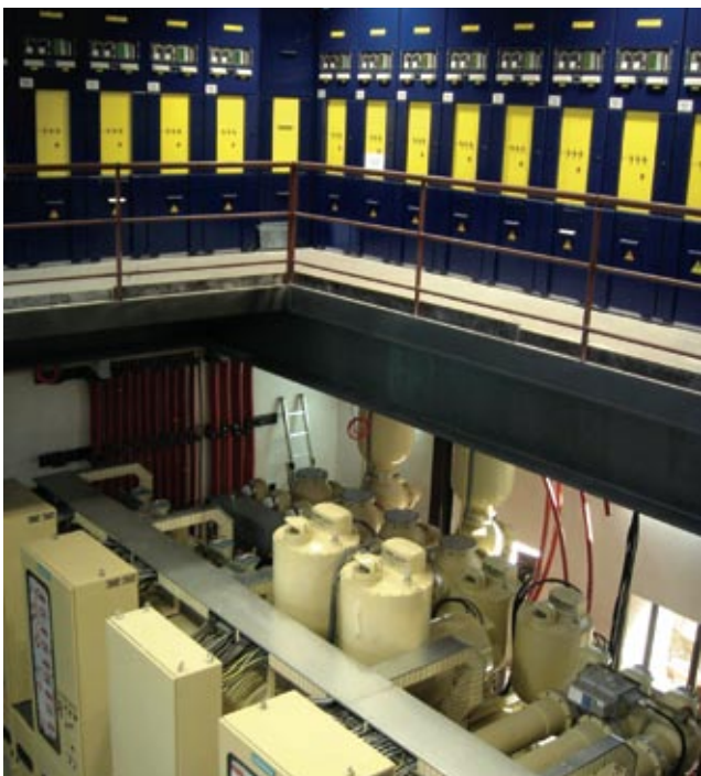
Detalle de las instalaciones de la Subestación Eléctrica de Puente de la Princesa, una vez blindada y compactada. 2005.
