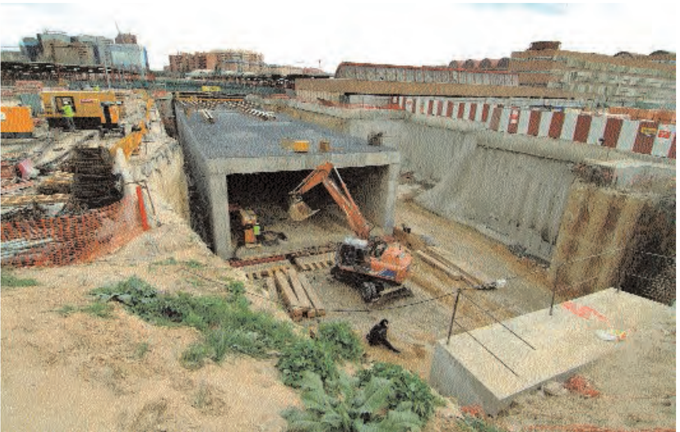
1 y 2: Túnel Norte, imágenes de julio de 2006. 3: Túnel Sur Cajones Este, imagen de enero de 2006. 4: Túnel Sur Cajones Oeste, imagen de marzo de 2006.
