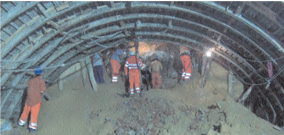
1, 2 y 3: Hormigonado de semilosa de cubierta, ejecución de pila-pilote y hormigonado de losa de solera en la c/ Sor Ángela de la Cruz. 4: Método tradicional (alemán), hormigonado de anillo y vista del frente de la excavación. 5: Fondo de Saco. Ejecución de pantalla continua. Imágenes tomadas en diciembre de 2006.
