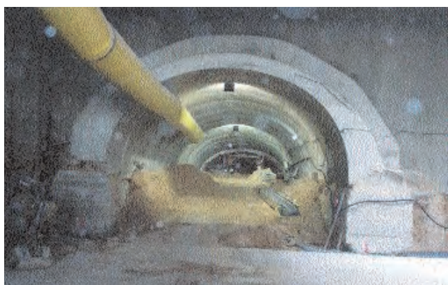
Distintas fases del proceso de construcción del túnel, año 2006.
