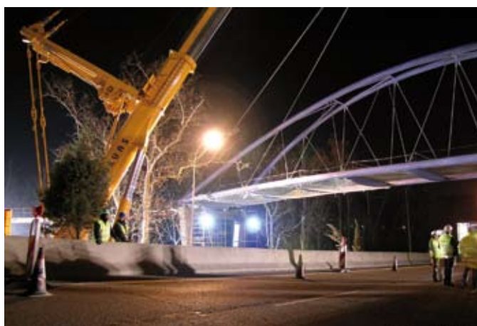
Imágenes durante el proceso de montaje de la pasarela sobre la ctra. Castilla
