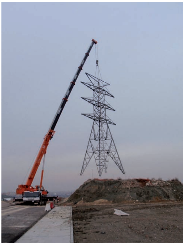
Desmontaje de la L-3A: LAT 132 kV DC Puente de la Princesa-Mercamadrid-Rivas a su paso por Mercamadrid. 2010
