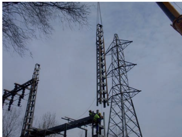
Desmontaje del doble circuito de 132 kV Estrella-Vicálvaro. 2010
