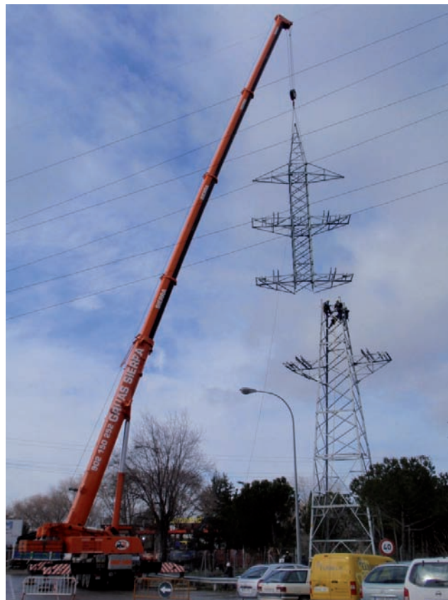
Desmontaje de la L-3A: LAT 132 kV DC Puente de la Princesa-Mercamadrid-Rivas a su paso por Mercamadrid. 2010
