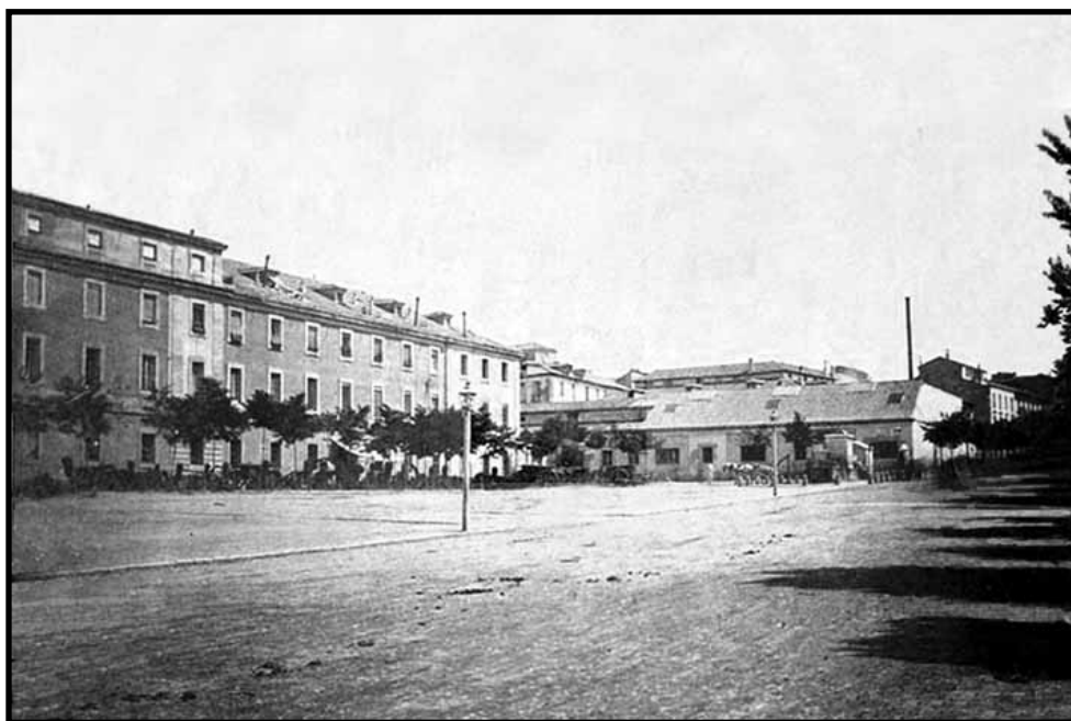
Comienzan las obras de demolición del Cuartel de San Gil
