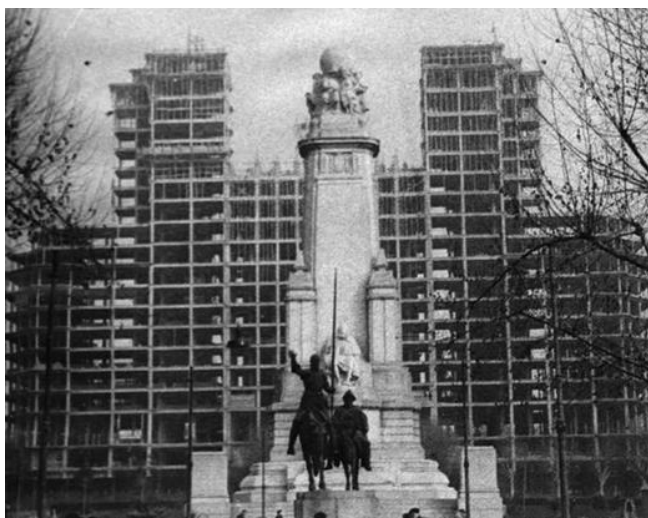
Izquierda: Edificio de Telefónica en Gran Vía. Estructura metálica (1926-1929). Foto de 1928. Arquitectos: L.S Weeks e I. Cárdenas. Derecha: Edificio España en construcción en una fotografía de febrero de 1950. Estructura de hormigón armado. Obsérvese la diferencia de luces entre pilares que después la fachada ocultará con un riguroso orden dando apariencia de perfecta geometría en la distribución de los huecos. La situación en planta de los pilares no responde a una retícula regular.
