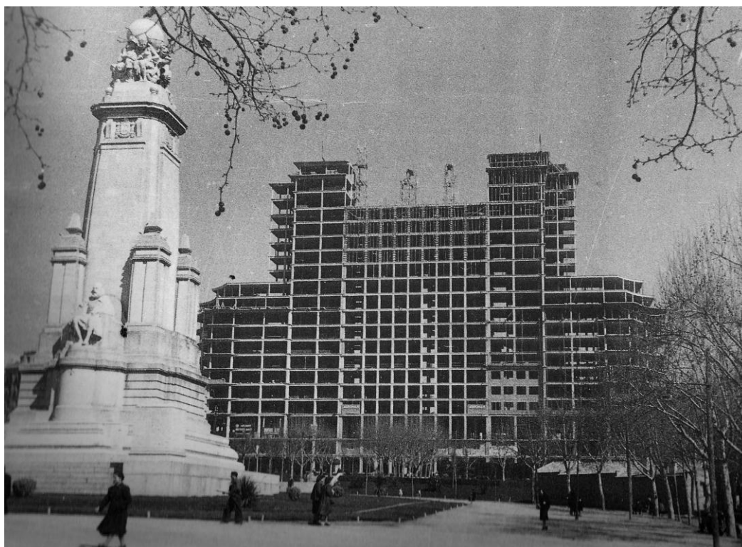
El Edificio España en construcción hacia 1950-1951. Obsérvense las distintas luces de los pórticos de hormigón, probablemente para hacer más resistente la estructura del cuerpo central sobre el que se elevaría la llamada “torre”. El regular reparto de huecos de la futura fachada oculta este hecho.
