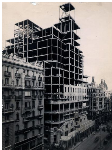
Izquierda: Edificio de Telefónica en Gran Vía. Estructura metálica (1926-1929). Foto de 1928. Arquitectos: L.S Weeks e I. Cárdenas. Derecha: Edificio España en construcción en una fotografía de febrero de 1950. Estructura de hormigón armado. Obsérvese la diferencia de luces entre pilares que después la fachada ocultará con un riguroso orden dando apariencia de perfecta geometría en la distribución de los huecos. La situación en planta de los pilares no responde a una retícula regular.
