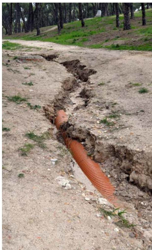
**Imagen 8.2.2.8** Antigua construcción de drenaje de la "Gran Cárcava" descubierta por la erosión. 2018.
