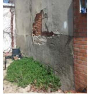
Desprendimientos del revoque de cemento en la divisoria con el Cantón de limpieza.
