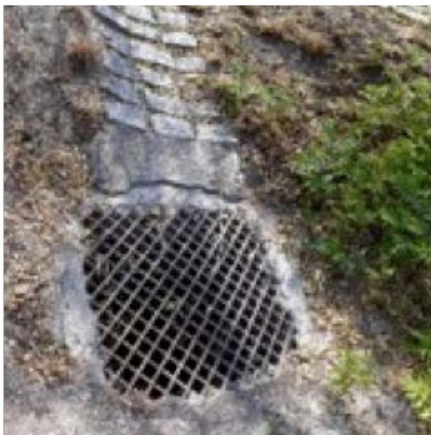
**Imagen 8.2.2.5** Desagüe incorporado en el final de una canaleta. 2018.
