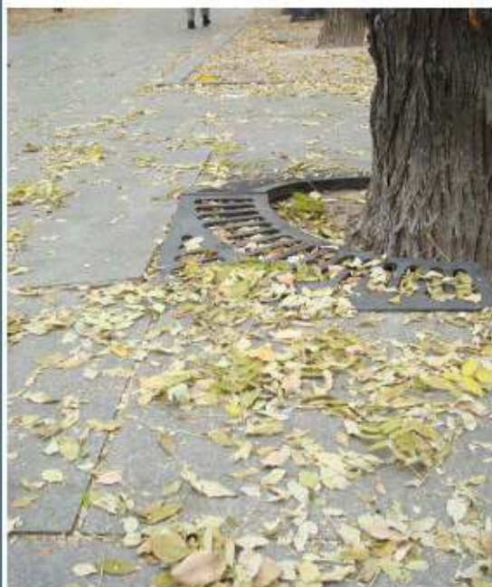
8. Abombamiento del pavimento
