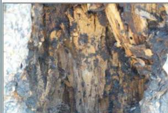
4.a Orificios de insectos perforadores de la madera descompuesta
