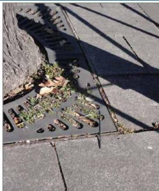
9. Deformación del terreno
