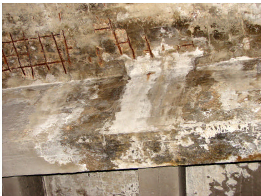
Armadura de la losa superior de forjado a la vista con síntomas de corrosión
