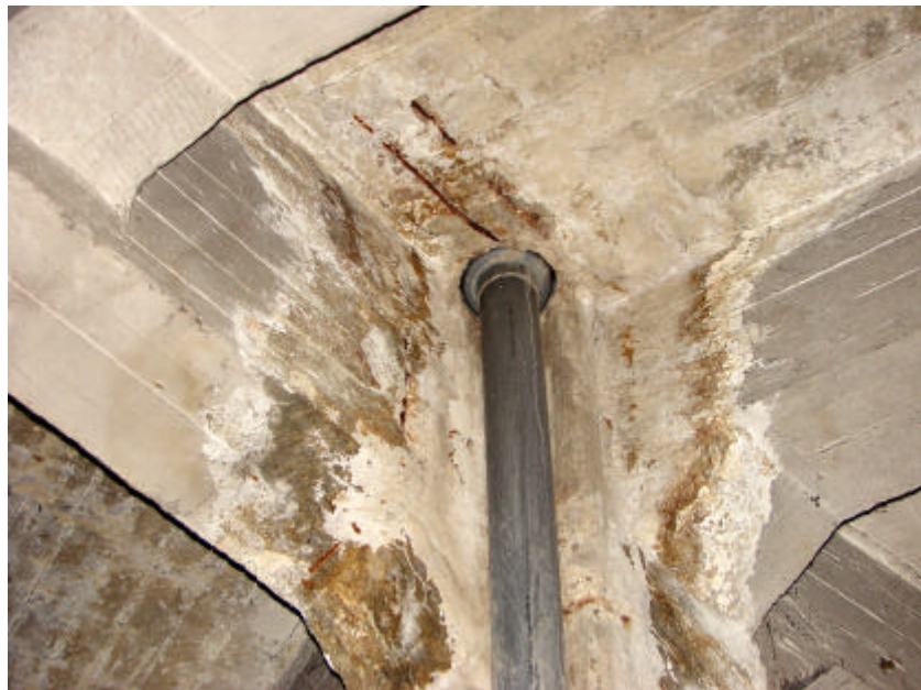
Fisuras y desconchones en elementos de estructura, que dejan armadura a la vista con síntomas de corrosión
