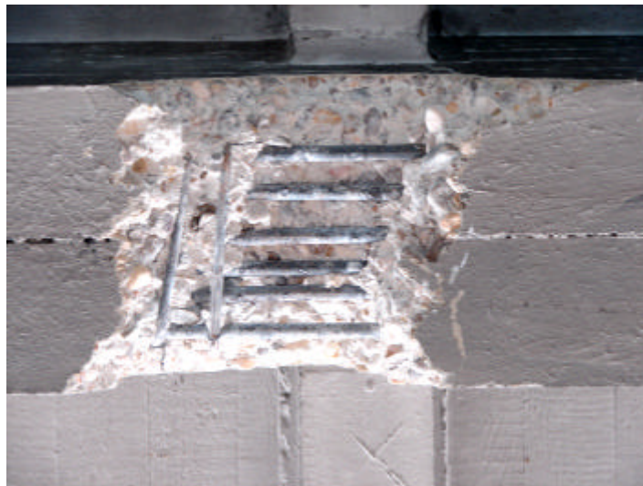
Cala realizada en una viga para descubrir la armadura de positivos
