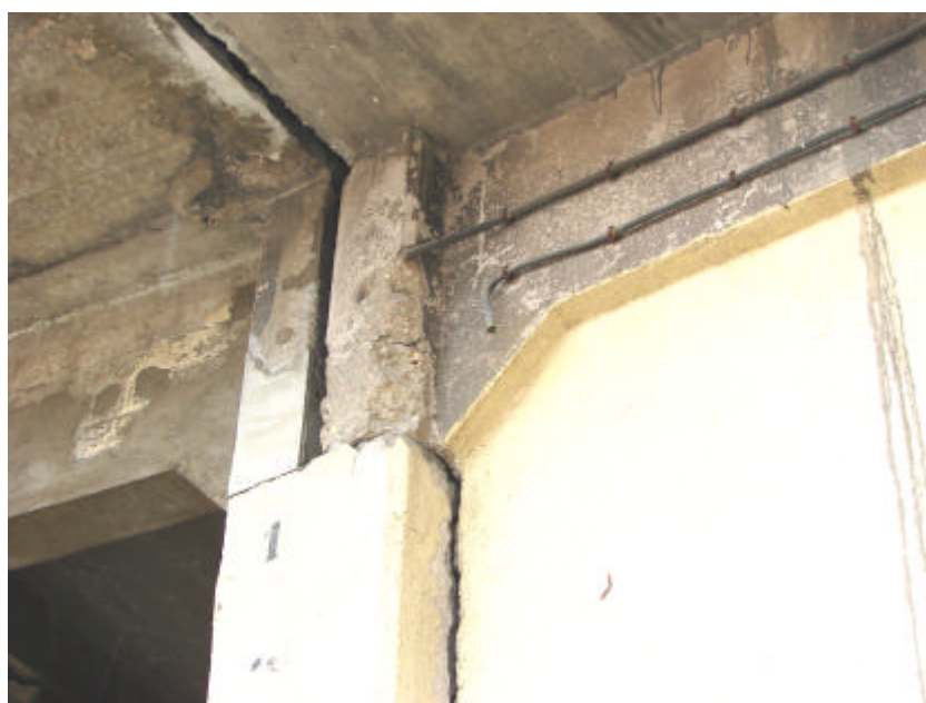
Fisuras y desconchones en vigas de cubierta, en zonas de juntas de dilatación
