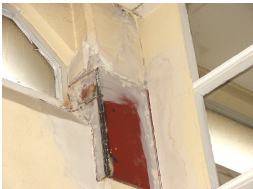
Fisuras en nudo pilar-viga de cubierta
