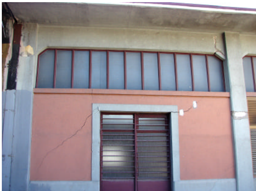
Fisuras en fachada y particiones interiores en la zona de esquina entre las fachadas de la Avenida de Manzanares y la adyacente al río
