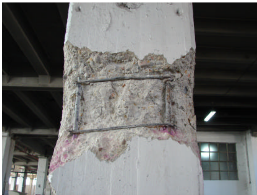
Calas realizadas en pilares de hormigón
