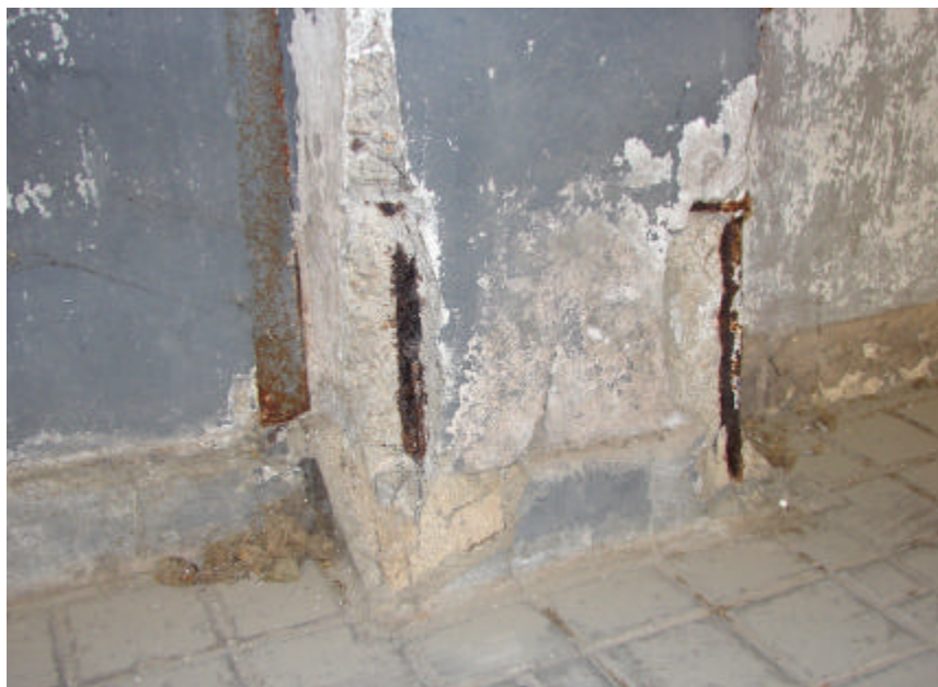
Fisuras y desconchones que dejan armadura a la vista con síntomas de corrosión en el arranque de un tramo de soporte
