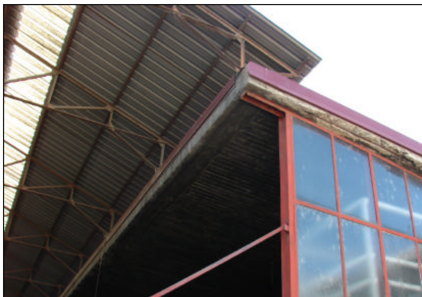
Detalle configuración voladizo y estructura de cubierta de la vía central
