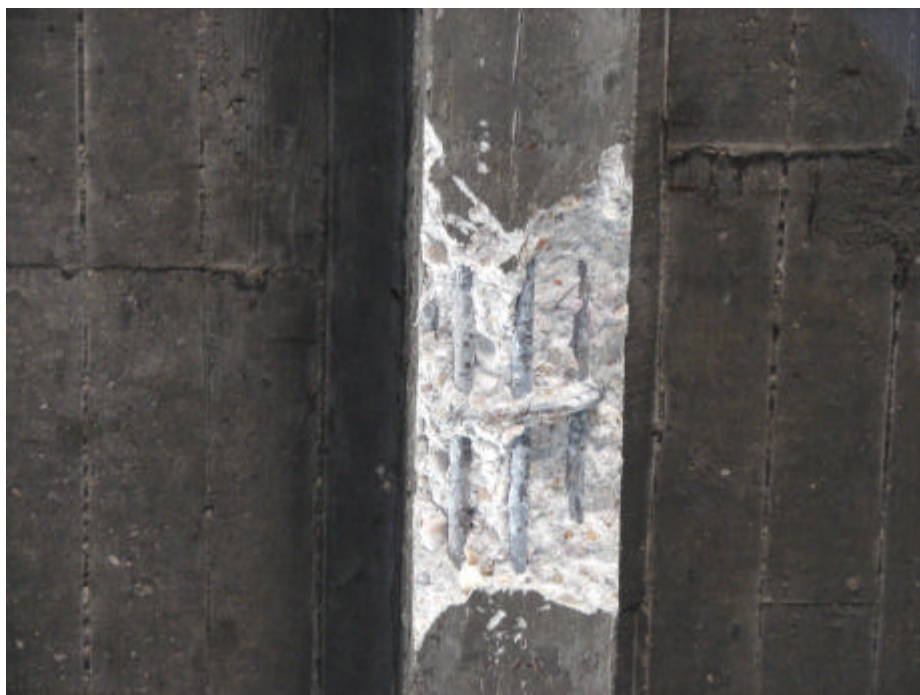
Calas realizadas para descubrir la armadura de positivos de los forjados
