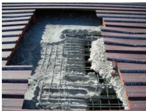
Detalle calas efectuadas en voladizos
