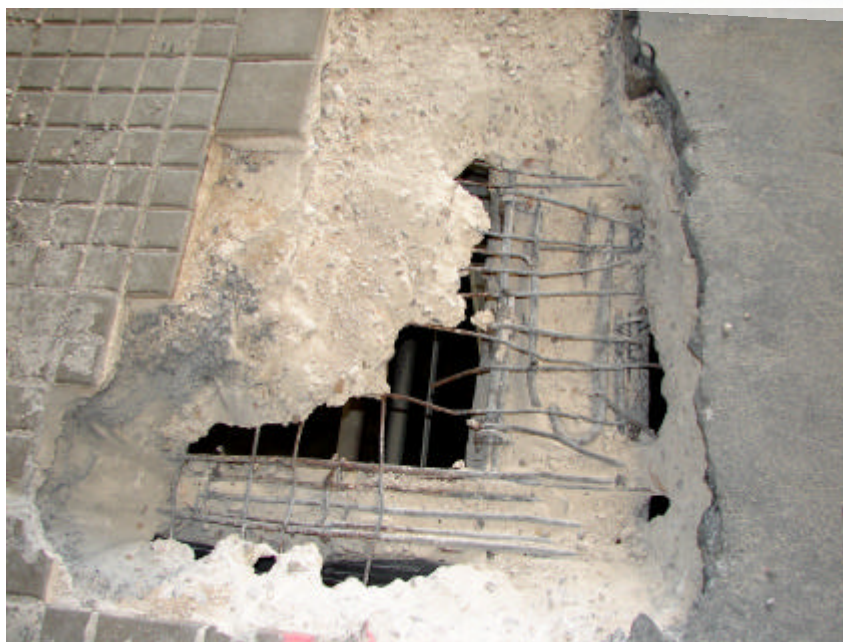
Calas realizadas para descubrir la armadura de negativos de los forjados
