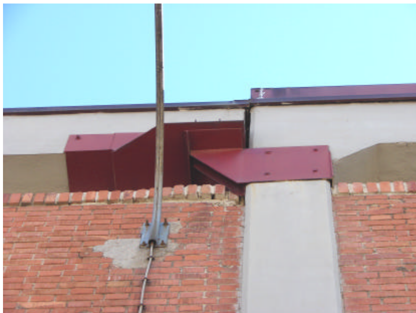
Véanse los refuerzos en una zona de junta de dilatación
