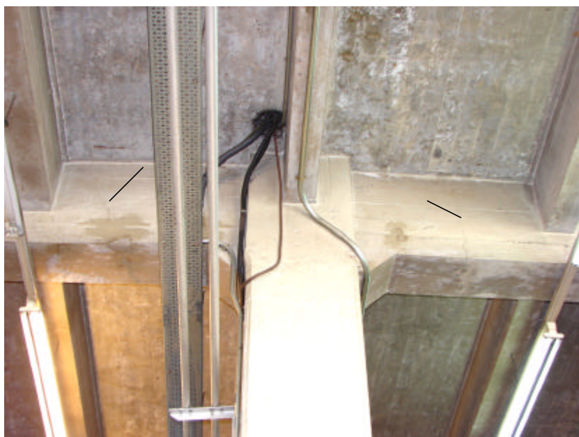
Fisuras en vigas
