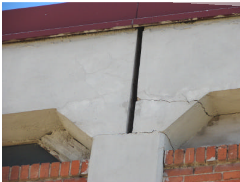
Fisuras en nudo pilar-viga de cubierta
