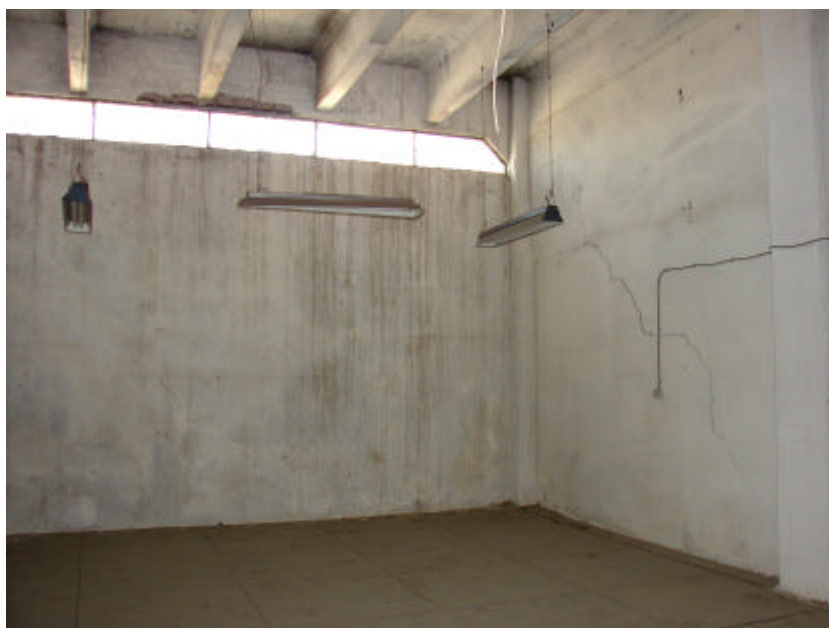
Véase una de las fisuras de trazado inclinado en una de las particiones de planta primera
