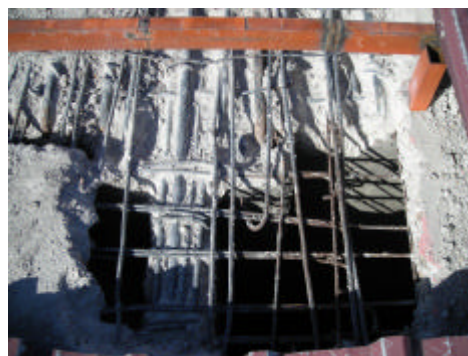
Detalle calas efectuadas en voladizos
