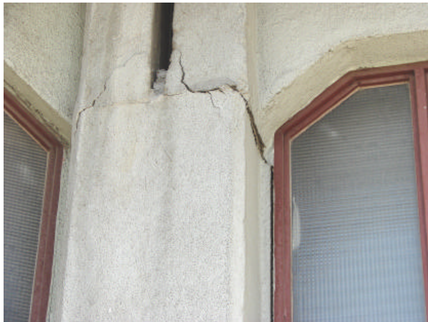
Fisuras y desconchones en vigas de cubierta, en zonas de juntas de dilatación
