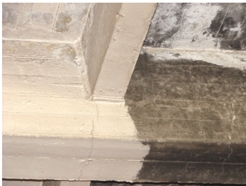
Fisura en viga en zona central de vano
