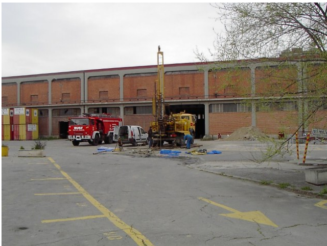
Sondeo S-7, efectuado con la sonda Mobill Drill B-50 de la empresa Macías Melgarejo S.L.
